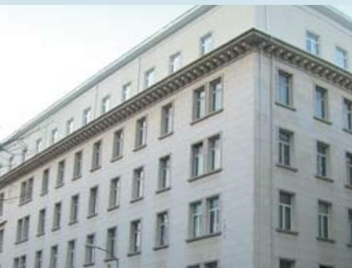
Grazie alla leggerezza garantita dalla tecnica costruttiva Knauf è stato possibile sopraelevare l'edificio di un piano senza che fosse necessario consolidarne ulteriormente la struttura primaria. Inoltre è stato possibile mantenere lo stesso stile della facciata originaria.
