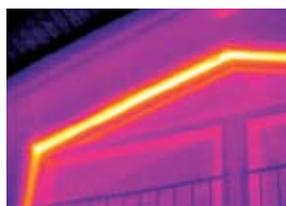
L'immagine ad infrarossi identifica i ponti termici. Ciò conduce a temperature delle superfici esterne più elevate. Tale termografia ad infrarossi mostra le imperfezioni nello strato isolante sulla facciata.
