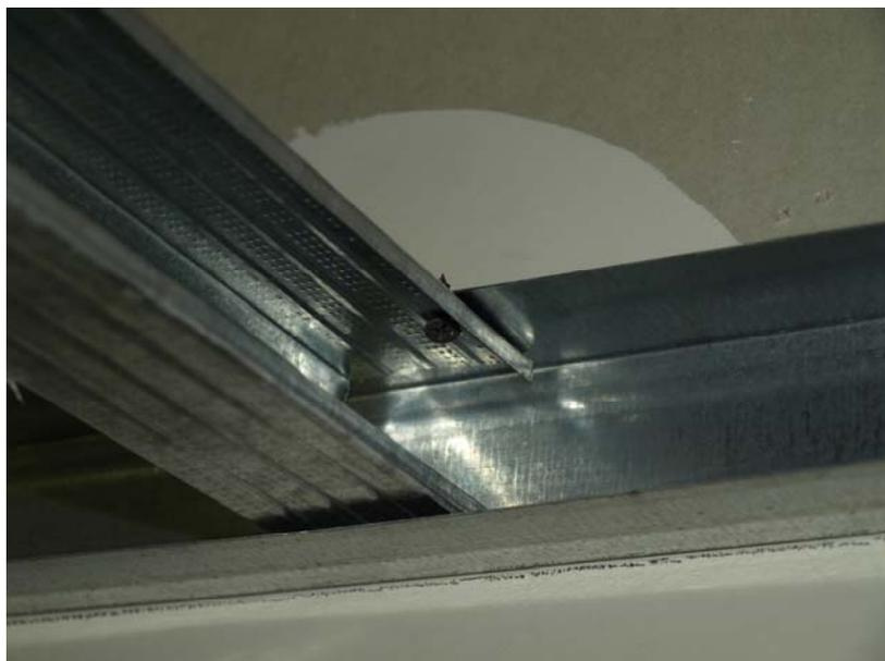
Assicurazione della posizione del profilo CW Rigips nel profilo UW mediante schiacciamento
