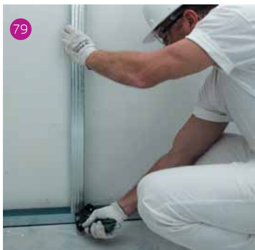
Fissaggio dei montanti tramite punzonamento.
