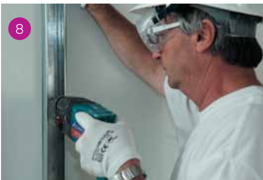
Avvitatura del montante ogni 40/50 cm con viti ad andamento a zig-zag. Si rammenta che, in caso di richiesta di prestazione acustica, la banda resiliente dovrà essere applicata sul dorso delle guide a pavimento e a soffitto e su quello dei montanti terminali per desolidarizzare il tramezzo dalle strutture limitrofe (solai, pareti, travi e/o pilastri).
