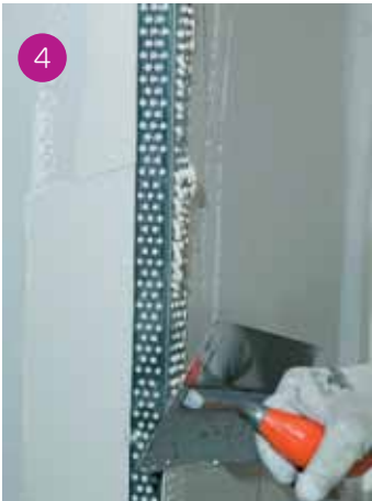
Riempimento dei due lati del paraspigolo.
