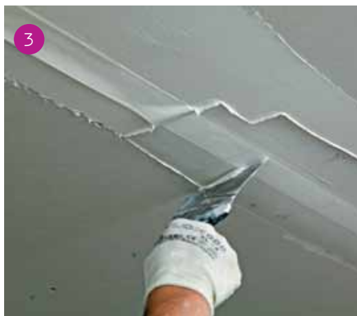
Serraggio della banda con rimozione delle sbavature.
