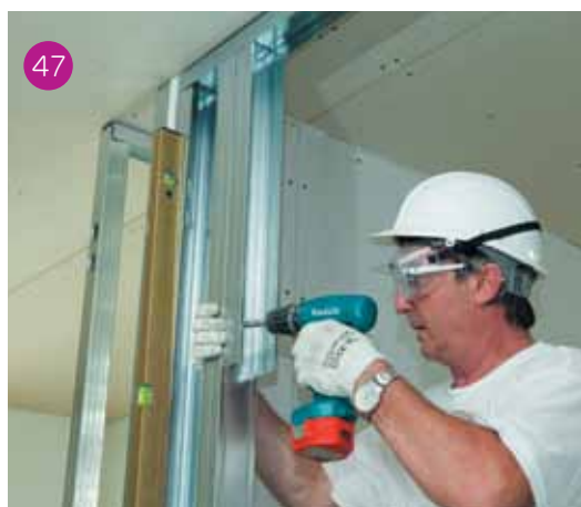
47 Posizionamento di spezzoni di montante sul dorso dei montanti di stipide.
