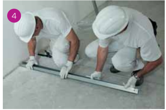
Applicazione della guida sulla traccia a pavimento.
