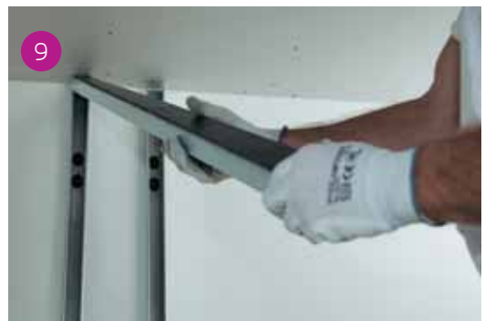
L'applicazione delle guide a soffitto avviene inserendole sulla testa dei montanti terminali.
