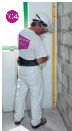
Verifiche di ingombro del pannello e di planarità della parete.
