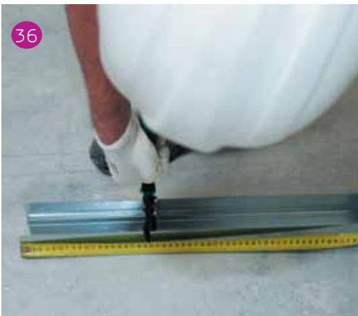
Taglio a "V" delle ali della guida a terra per permettere la rotazione di 90° che consentirà il blocco al piede dei montanti costituenti il vano porta.
