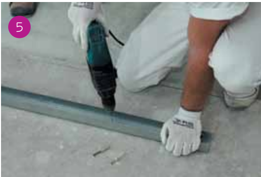
Fissaggio della guida tramite avvitatura con tasselli ogni 50 cm.
