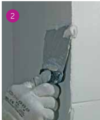
2 Imburraggio dello spigolo con lo stucco.
