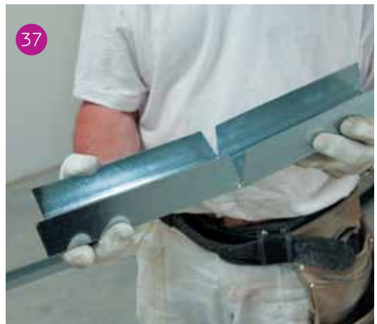
Taglio a "V" delle ali della guida a terra per permettere la rotazione di 90° che consentirà il blocco al piede dei montanti costituenti il vano porta.
