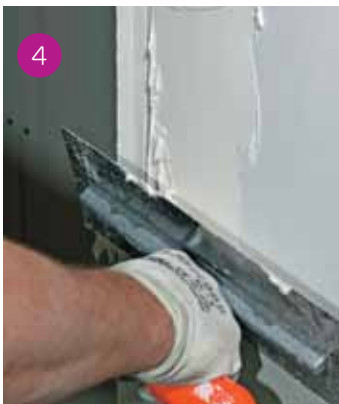
4 Serraggio della banda con l'americana.
