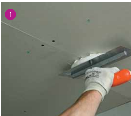
Imburraggio del giunto trasversale Synia.
