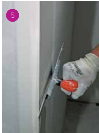
Rasatura dopo asciugatura della mano di riempimento.
