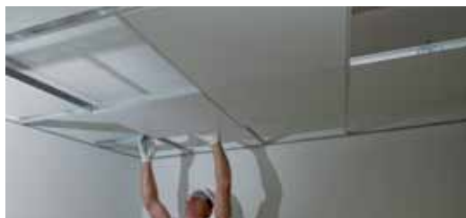
PROSECUZIONE DELLA POSA DEI PANNELLI
