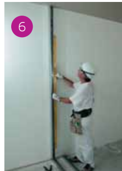
La parete può essere tracciata con il laser o con il pratico sistema utilizzato: si posizionano i montanti a ridosso della parete di partenza e si fissano verticalmente con il controllo della livella magnetica.
