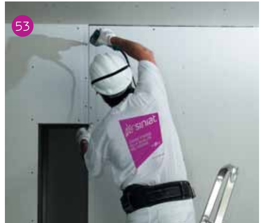
Applicazione e ritaglio "a bandiera" della 2 a lastra con seghetto manuale e definizione del vano porta.
