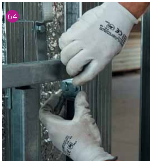
64 Applicazione delle piastre della traversa di controventatura del supporto e loro bloccaggio ai montanti.
