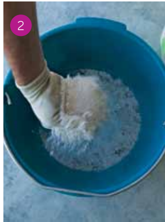
2 Spolverare la polvere fino a ricoprire la superficie dell'acqua.
