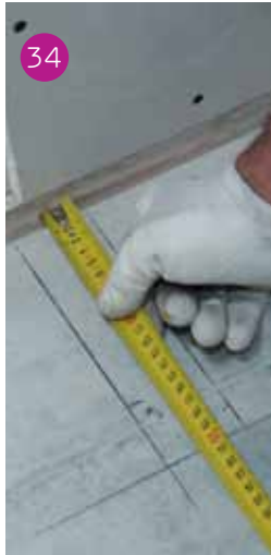
Tracciamento con filo tracciante. (fig. 33). Definizione del vano porta (fig. 34 - 35).
