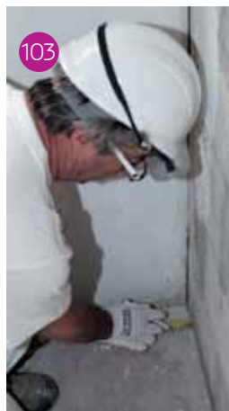
Verifiche di ingombro del pannello e di planarità della parete.
