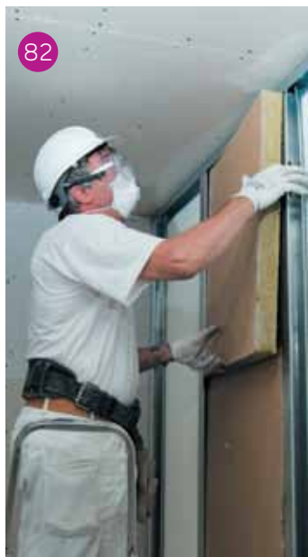
Inserimento del pannello isolante in lana di roccia.
