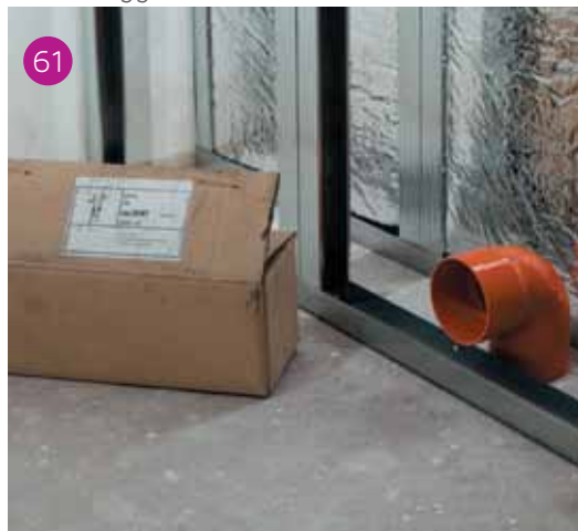
61 Gomito di scarico WC posizionato e la scatola del supporto.
