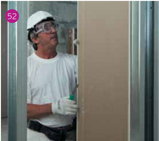
Applicazione e ritaglio "a bandiera" della lastra con seghetto manuale.
