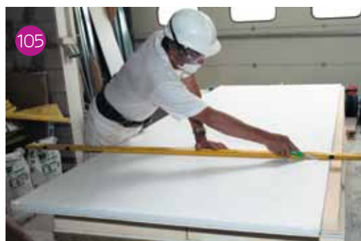
Taglio trasversale del pannello isolante nel caso di ensioni d'imbarco. Può succedere, a volte, con spessori di isolante superiori a 3 cm.
