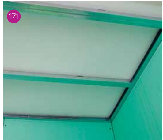
171 Profili applicati. L'interasse tra gli attacchi è a passo di 100 cm.
