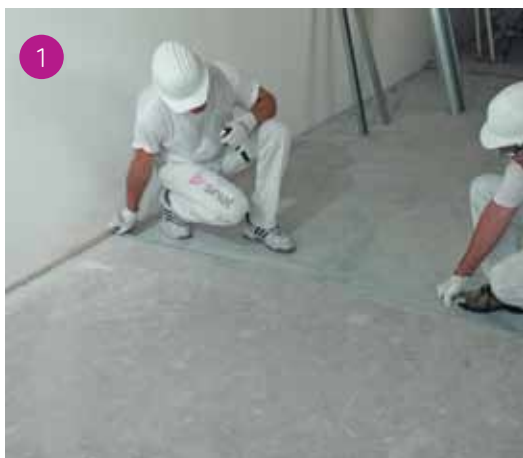
Tracciamento con filo tracciante per la realizzazione di un tramezzo di tipo S.
