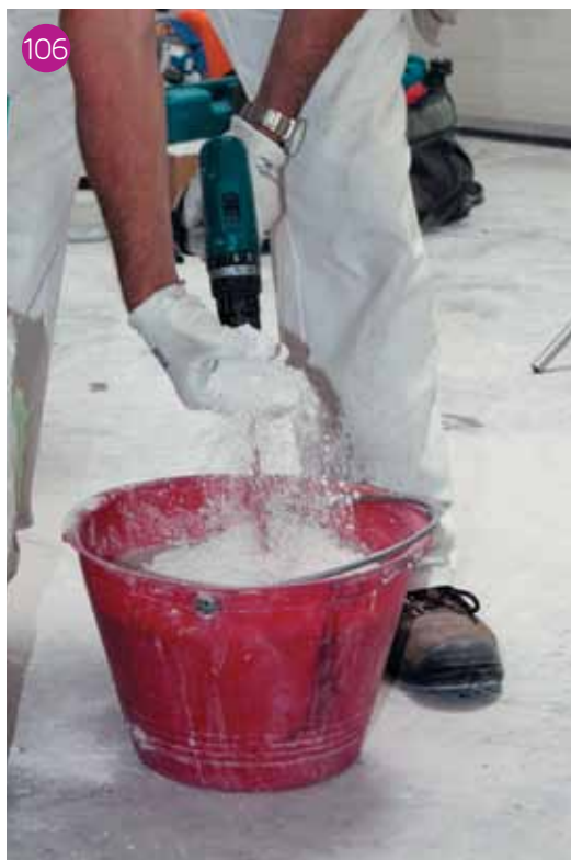
Miscelazione del collante a mezzo miscelatore elettrico sempre raccomandato.
