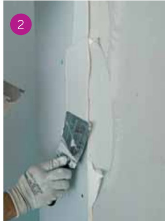
Imburraggio dello spigolo.
