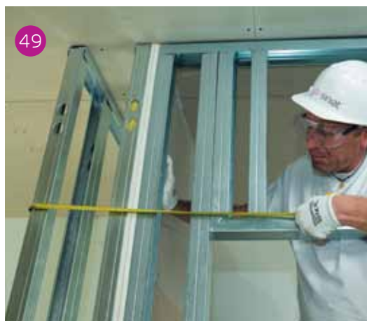
49 Misurazione per la definizione della larghezza della lastra "a bandiera" verso il sopra luce porta (fig. 49). Al fine di non creare linee di debolezza, in caso di sollecitazione dinamica violente nell'uso delle porte, si deve evitare di posizionare giunti in corrispondenza degli stipiti: il montante intermedio inserito nel sopra luce serve al fissaggio del ritaglio "a bandiera" della lastra.
