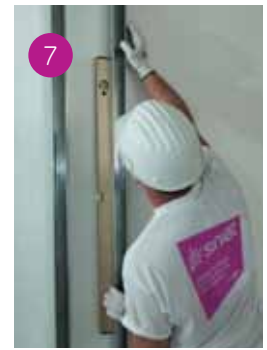
La parete può essere tracciata con il laser o con il pratico sistema utilizzato: si posizionano i montanti a ridosso della parete di partenza e si fissano verticalmente con il controllo della livella magnetica.
