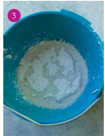
3 Lasciar riposare qualche minuto per consentire l'idratazione della polvere.
