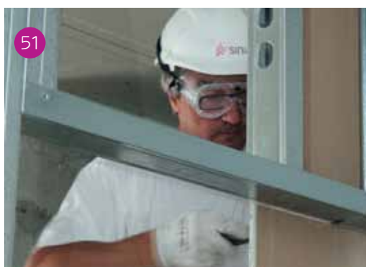
49 Misurazione per la definizione della larghezza della lastra "a bandiera" verso il sopra luce porta (fig. 49). Al fine di non creare linee di debolezza, in caso di sollecitazione dinamica violente nell'uso delle porte, si deve evitare di posizionare giunti in corrispondenza degli stipiti: il montante intermedio inserito nel sopra luce serve al fissaggio del ritaglio "a bandiera" della lastra.
