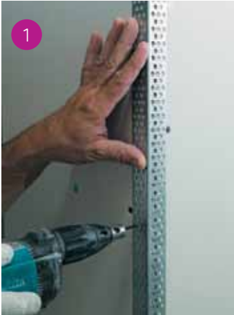
Fissaggio del paraspigolo tramite avvitatura.
