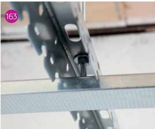
Dettaglio d'incastro tra profilo primario e secondario.
