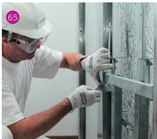
64 Applicazione delle piastre della traversa di controventatura del supporto e loro bloccaggio ai montanti.
