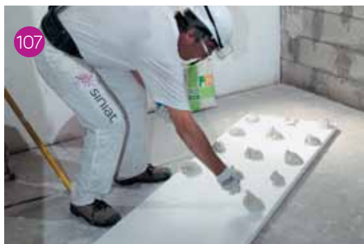
Applicazione di "plots" di collante su pannello di espanso.
