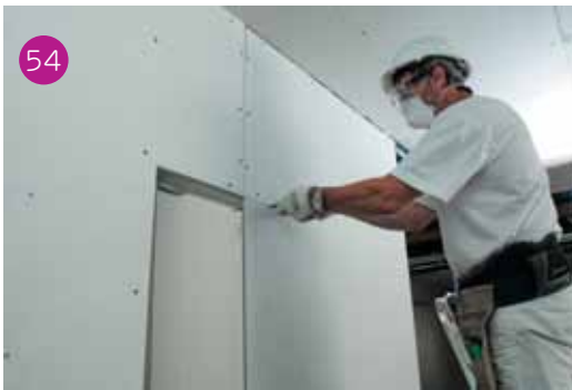
Applicazione e ritaglio "a bandiera" della lastra con seghetto manuale.
