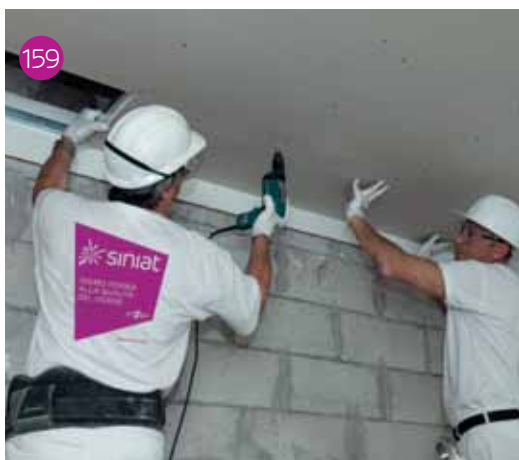
159 Installazione della lastra.
