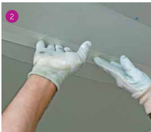
Applicazione della banda.
