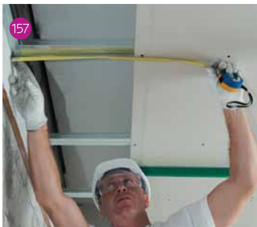
157 Misurazione della larghezza della banda di lastra a chiusura del controsoffitto. Si devono considerare un paio di millimetri in meno per evitare tensioni superficiali del controsoffitto legate alle dilatazioni termiche dei profili.
