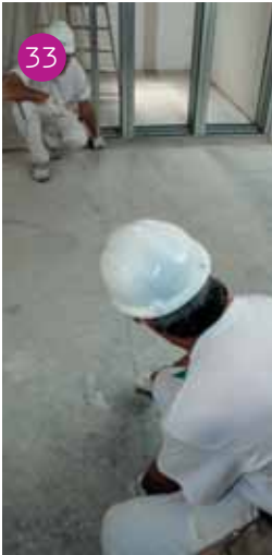
Tracciamento con filo tracciante. (fig. 33). Definizione del vano porta (fig. 34 - 35).
