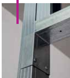
48 Fissaggio della guida ad architrave del vano porta. Nel dettaglio la configurazione a squadra della guida d'architrave.
