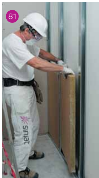
Inserimento del pannello isolante in lana di roccia.
